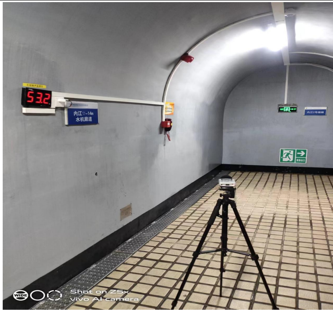
现场调查、现场采样及检测证明图像
